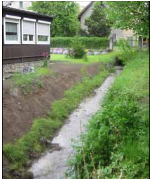
Abb. 9: Sehr schädlich für das Ökosystem Fließgewässer ist eine unangepasste Gewässerunterhaltung, hier in einem von Steinkrebsen und Bachmuscheln besiedelten Zufluss der Argen in Oberschwaben zu sehen. (M. Pfeiffer, 09.05.2012)
